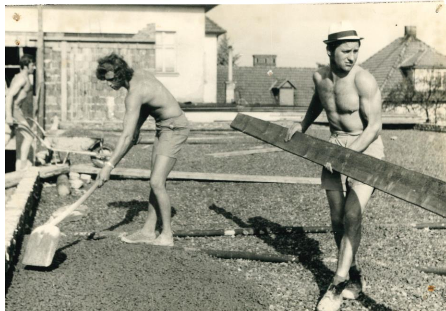
Záběry ze zahájovacích prací výstavby školky s kotelnou a klubovnou v akci "Z". Betónáž podkladní betonové desky. Vpravo vyzdívka pilířů a stěn školky.
