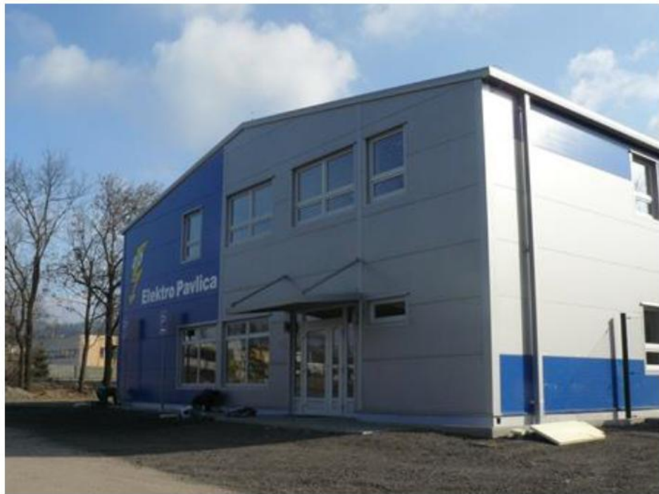
Provozně obchodní centrum společnosti Elektro Pavlica v Rožnově pod Radhoštěm.
