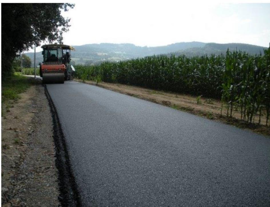
Výstavba cyklostezky údolím řeky Bečvy v úseku Horní Bečva – Veselá.
