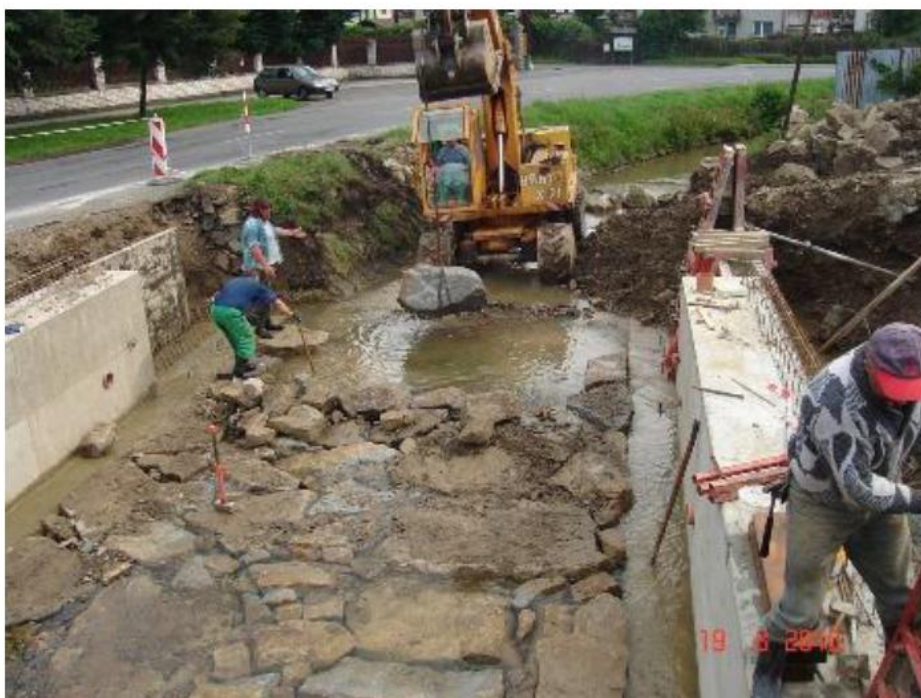
Oprava mostu a úprava vodního toku v Hošťálkově.
