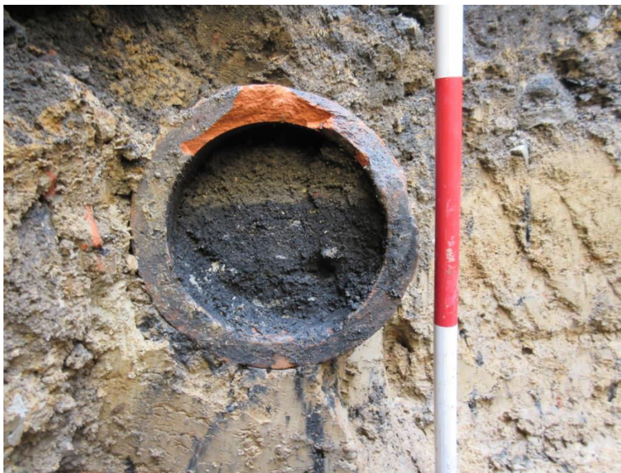
Obr. 21. Průřez keramickým potrubím (903).
