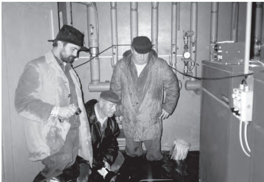
Čerpání vody v kotelně kina - povodeň v roce 1997
