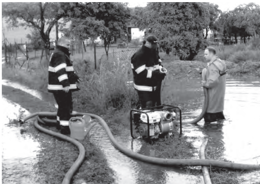
Likvidace následků povodně za pomoci ZÚ HZS Hlučín
